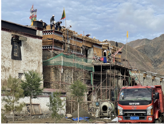
〈사진 1〉 복원 중인 샤루사 부속 건물 사진: 저자 촬영(2023.8.9.)
